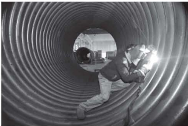
工人师傅正在燃气热载体炉体内焊接炉管
