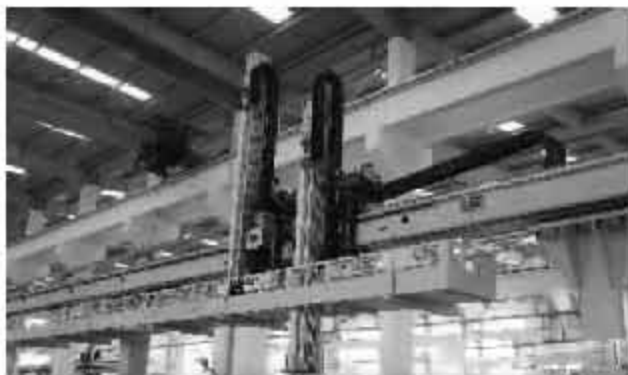
桁架机器人在作业
