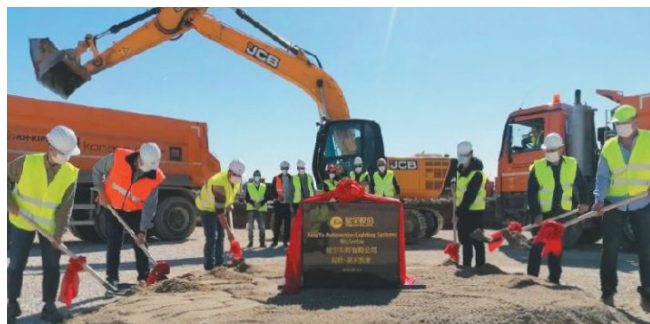
星宇股份塞尔维亚项目奠基
