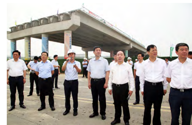
督查大明路跨沪蓉高速大桥项目
